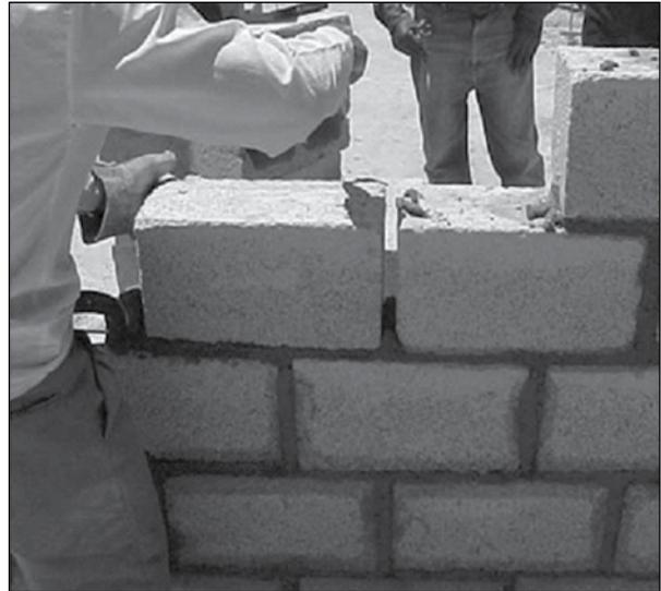
Figura 8 ■ Colocación de mampostería bloque hueco en fraccionamiento de Tuxtla Gutiérrez, Chiapas.
