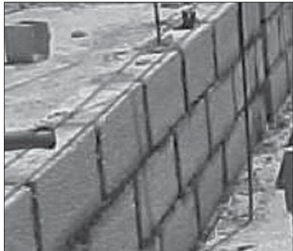
Figura 7 ■ Mampostería típica en el estado de Chiapas. Se observa que las piezas son huecas, pero se fabrican con una cubierta para facilitar la construcción, la cual al perforar para que el concreto penetre en el alveolo (huevo por donde debe pasar el mortero) termina por romper la pieza o por obstruir la continuidad del castillo interno.
