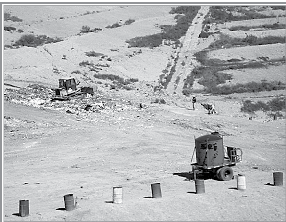
Figura 13 ■ Quemadores de biogas instalados en el RS de Tlalnepantla de Baz.
