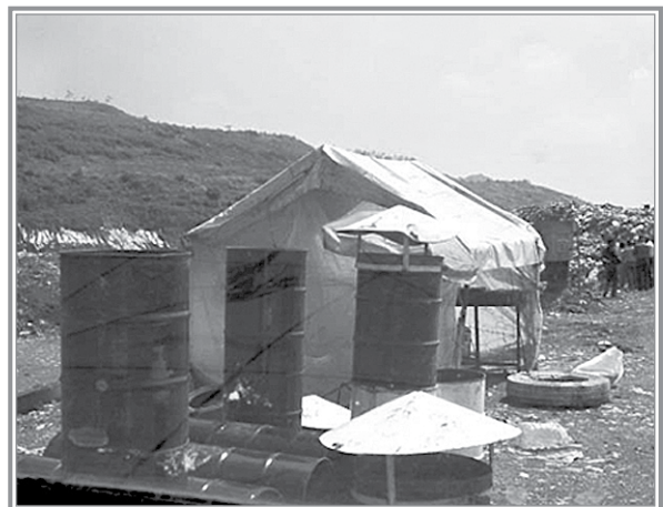
Figura 13 ■ Quemadores de biogas instalados en el RS de Tlalnepantla de Baz.
