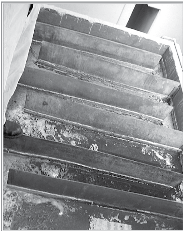
Figura 4 ■ | Tanque sedimentador provisto de mamparas.
