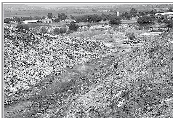
Figura 10 ■ | Zona de traslape entre celda 1 y 2.
