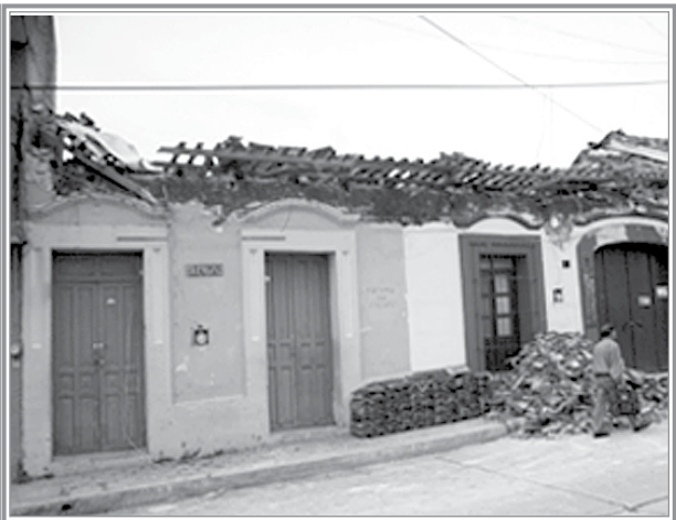
Figura 8 ■ | Características de las viviendas de la colonia y colapso de cubierta en la calle real de Guadalupe.
